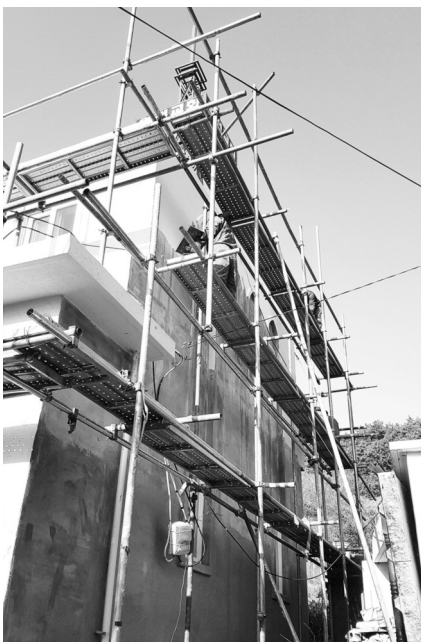
외벽 수리 중인 월전교회.
