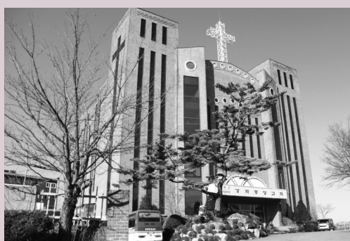
강화중앙교회(인천광역시 강화군 강화읍 청하동길 36).
