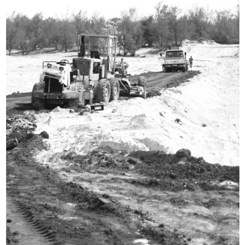
현재 공사 중인 사막 도로.
