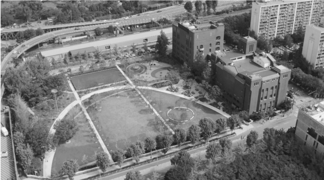
1단계 공사가 완료된 북측 동빙고 근린공원 전경.
