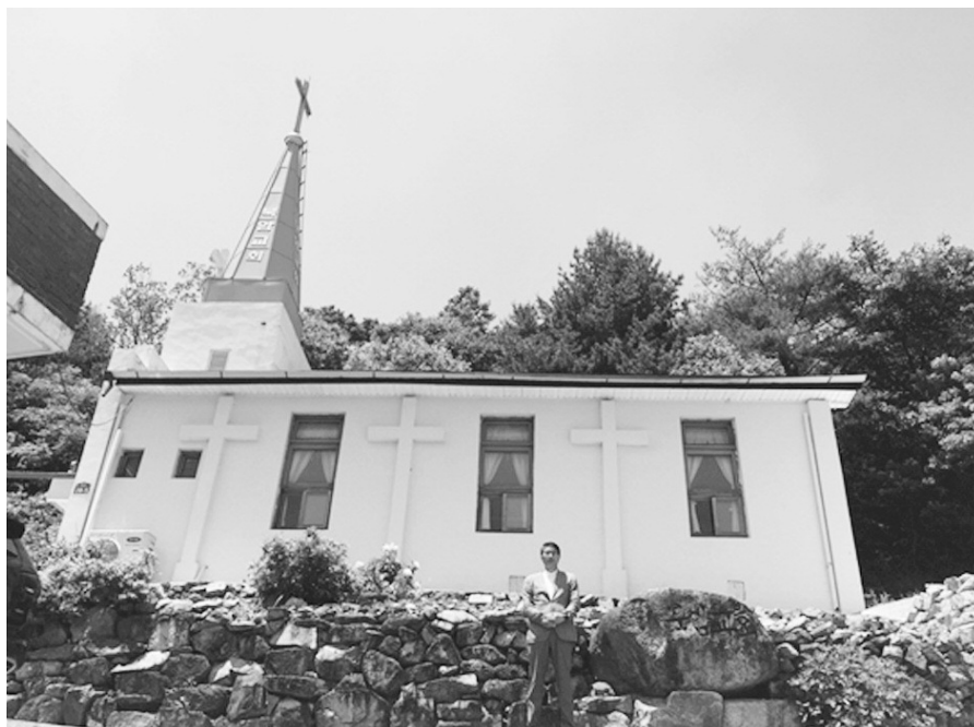
북암교회가 경기A공동체의 도움으로 수도 공사, 사택 보수, 웅벽 공사를 끝마쳤다.
