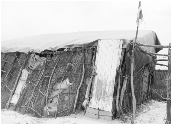
공사 전 갈대로 만든 학교.
